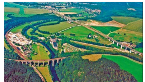
Luftbild, aufgenommen während der Bauarbeiten an der Neubaustrecke Hetzdorf. Im Vordergrund der alte Hetzdorfer Viadukt, rechts im Bild die beiden neuen Großbrücken über die Flöha und den Hetzbach. Links im Bild die Taktfertigungsstätte.
