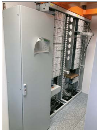
Jeder Adresspunkt hat im POP eine eigene Spleißkassette und muss entsprechend mit Glasfasern belegt und verbunden (gespleißt) werden.
