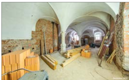
Eingangshalle im Foyer während des Umbaus Foto: Thomas Kruse
